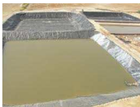
Balsas de evaporación final
